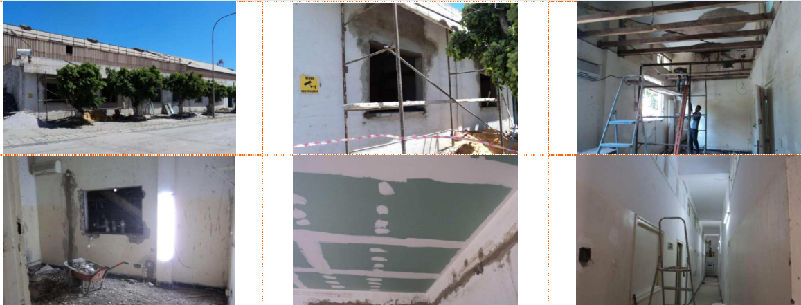
Travaux de rénovation de la DGM
