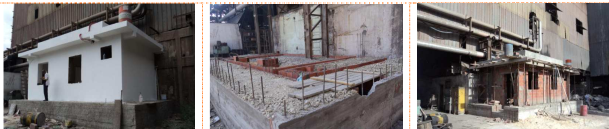
Travaux d'entretien et réparation de la structure des trémies à chaux N°1, 2 et 3
