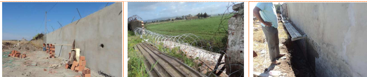
Réparation de la clôture d'EL FOULADH
