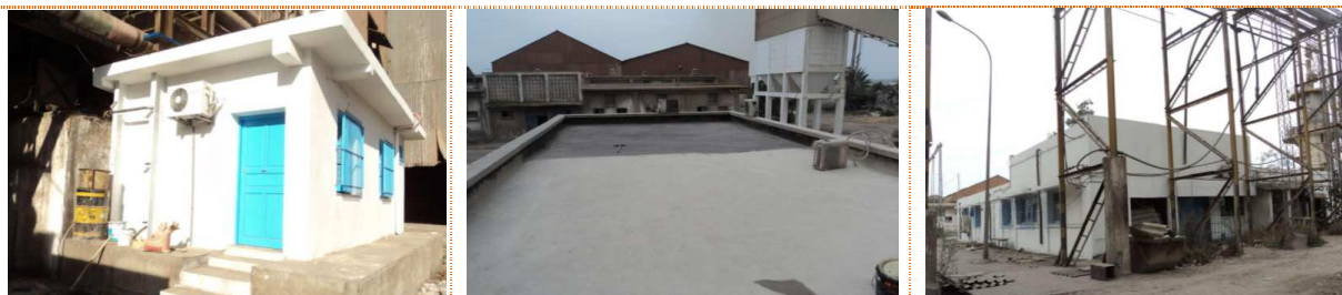
Travaux de réhabilitation du Bâtiment de la DCRM
