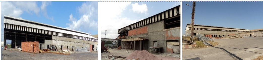
Le projet de reconstruction des murs de l'atelier de galvanisation et d'un bloc sanitaire à la sous-direction exploitation auprès de l'usine des structures Métalliques
