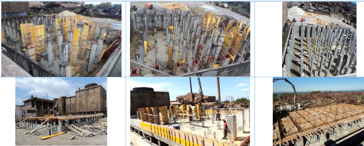
Les travaux de remplacement des deux tours de refroidissement
