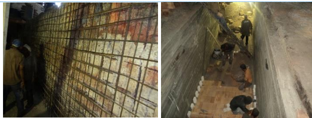
Les travaux de réfection & d'aménagement du Laminoir
