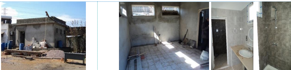
Les travaux de construction de vestiaires pour le personnel du service ferrailles
