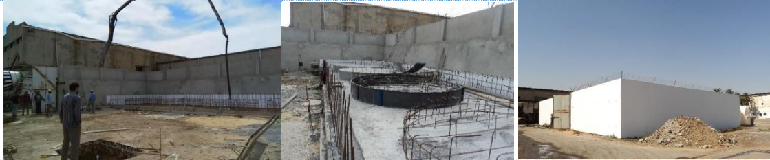
Le projet des travaux de réfection et de réparation du parc de stockage des produits chimiques du tréfilerie
