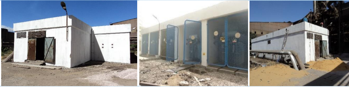
Le projet des travaux d'entretien de la sous station électrique de l'aciérie
